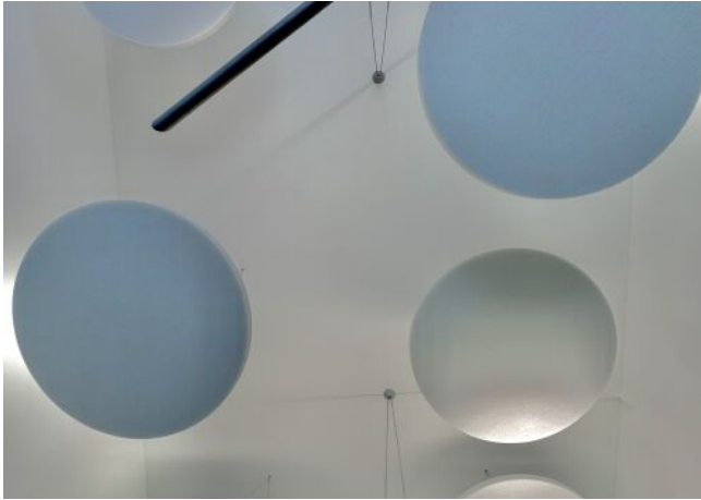
Schallabsorber und Beleuchtung
