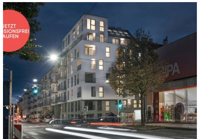
Arndtstraße 50 | Fassade Nacht
