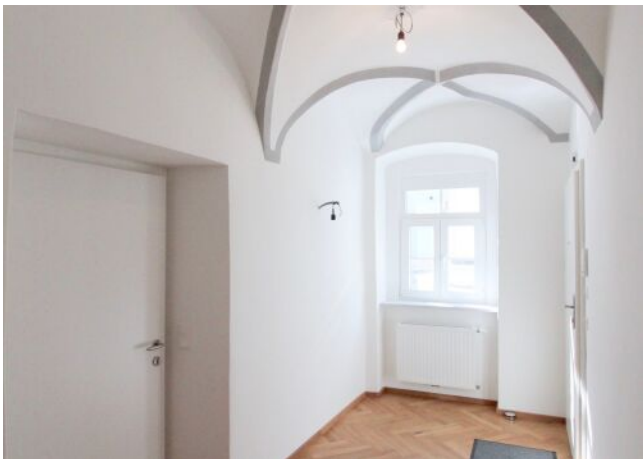
Kreuzgewölbe im Wohnbereich
