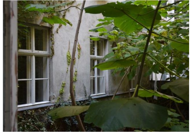
Innenhof zwischen den Trakten
