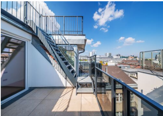
Terrasse & Aufgang Dachterrasse
