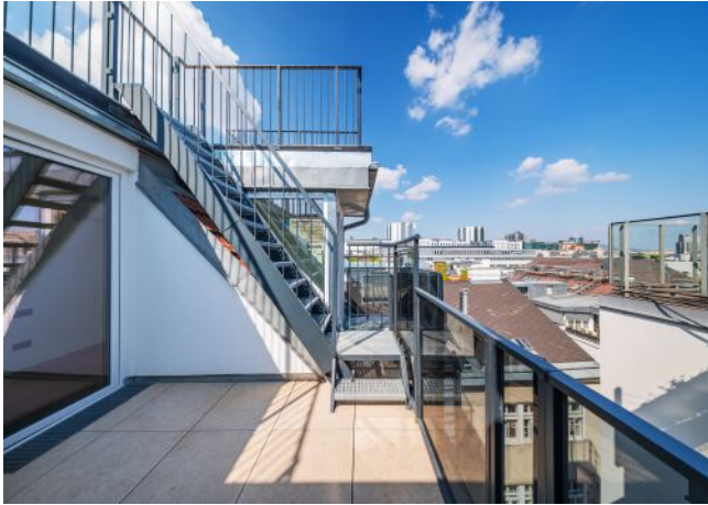
Terrasse & Aufgang Dachterrasse
