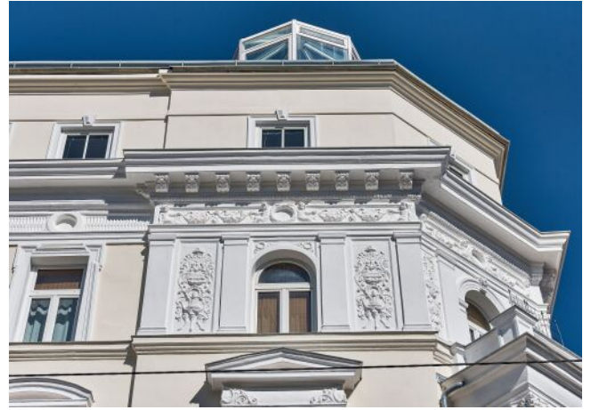
Leibenfrostgasse 8 | Fassade Detail
