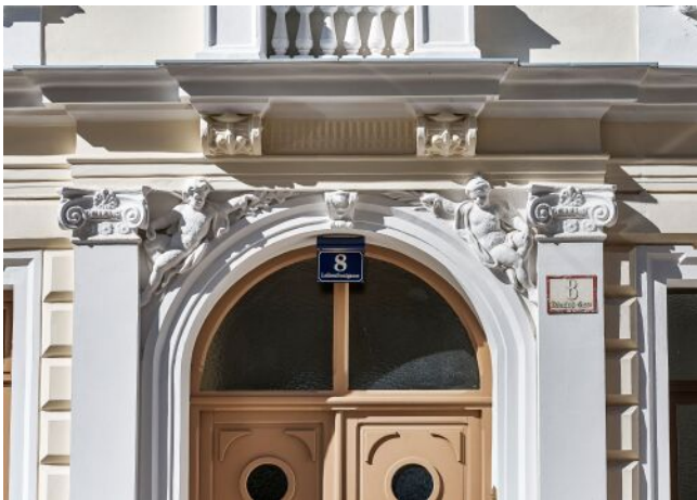
Leibenfrostgasse 8 | Fassade Detail
