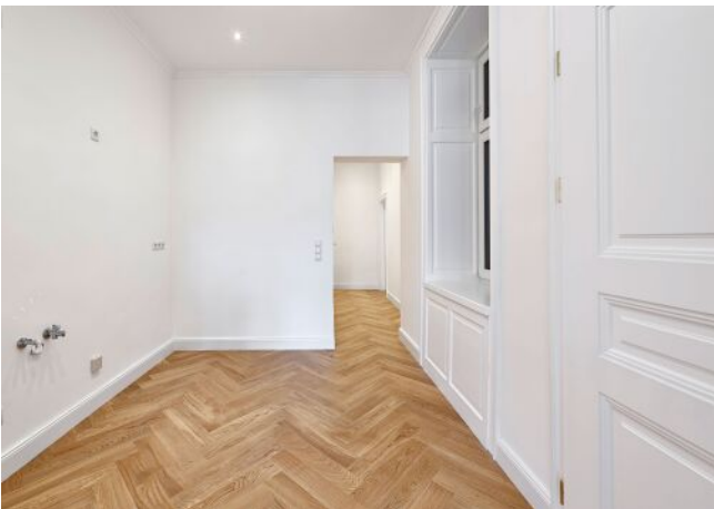
Küche | Beispiel Sanierung
