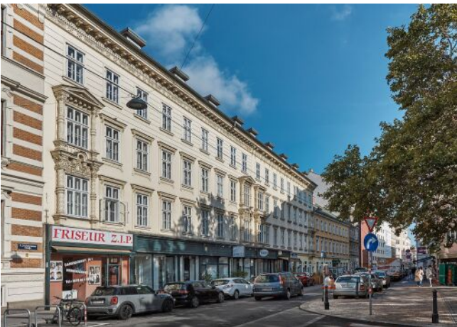
Schönbrunner Straße 20-24 | Fassade
