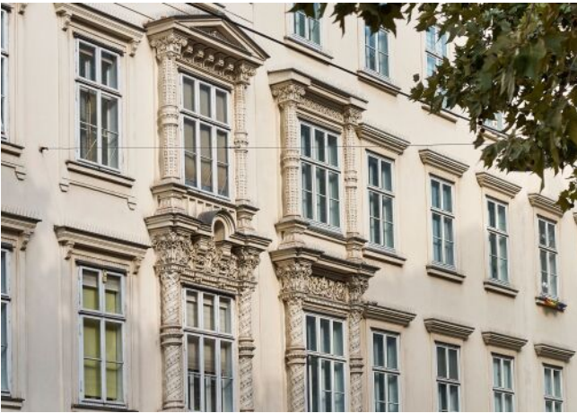
Schönbrunner Straße 20-24 | Fassade
