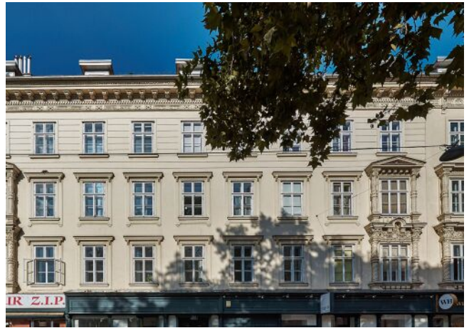
Schönbrunner Straße 20-24 | Fassade
