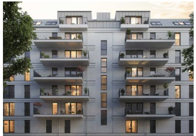
Wiedner Hauptstrasse 140 | Fassade Straße
