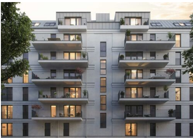
Wiedner Hauptstrasse 140 | Fassade Straße
