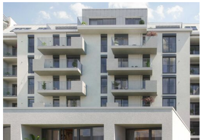
Wiedner Hauptstrasse 140 | Fassade Hof
