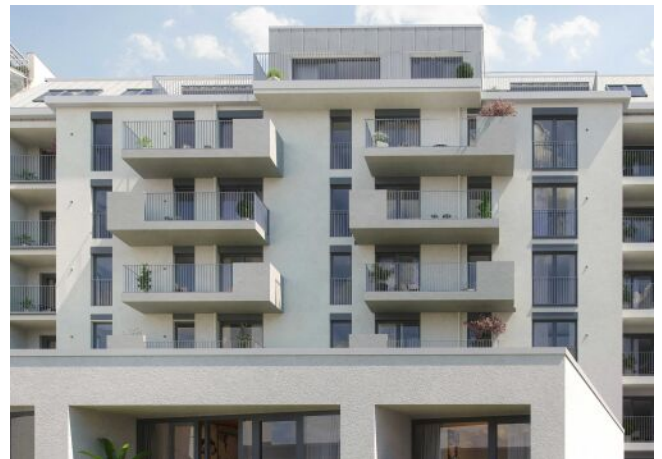
Wiedner Hauptstrasse 140 | Fassade Hof
