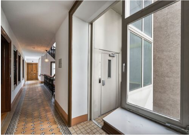
Stiegenhaus mit Lift
