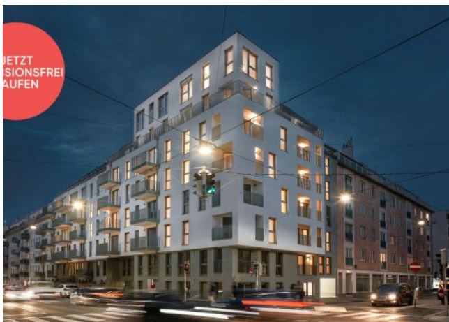
Arndtstraße 50 | Fassade Nacht
