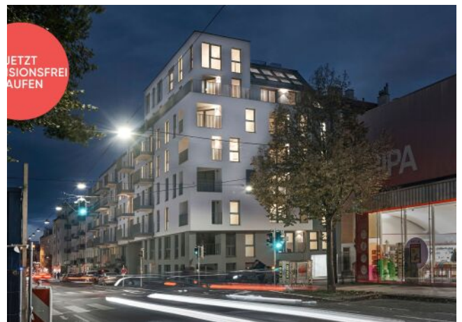
Arndtstraße 50 | Fassade Nacht
