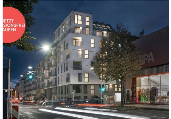
Arndtstraße 50 | Fassade Nacht
