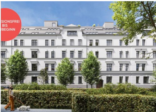
Roseggasse | Fassade Frontal
