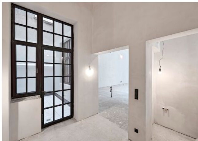
Vorraum mit Terrasse
