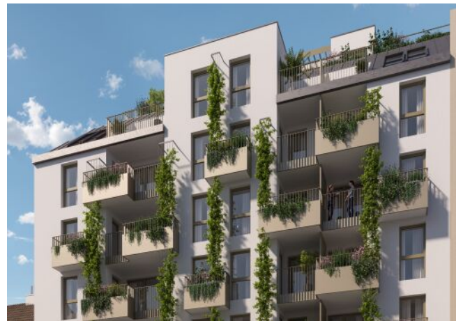
Ottakringer Straße 26 | Fassade Tag
