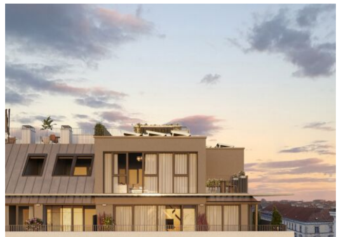
Herbststraße 6-10 | Außenansicht | Dämmerung
