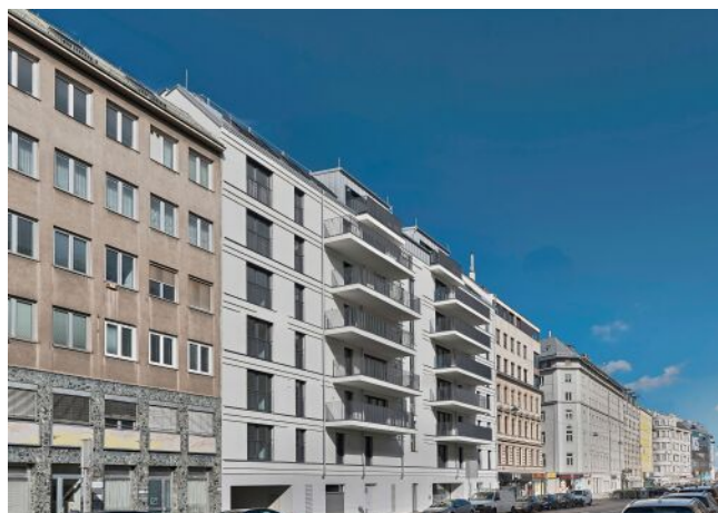
Wiedner Hauptstraße 140 | Hausansicht
