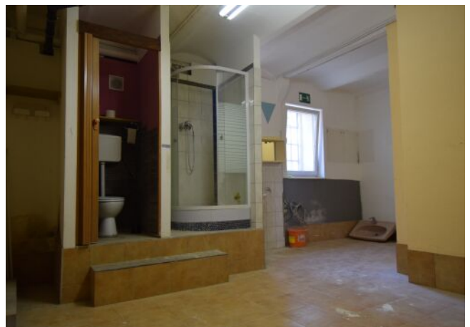
Raum 1 WC und Dusche
