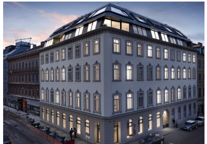
Essenz No. 1 | Fassade Abend
