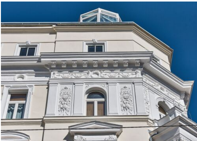
Leibenfrostgasse 8 | Fassade Detail
