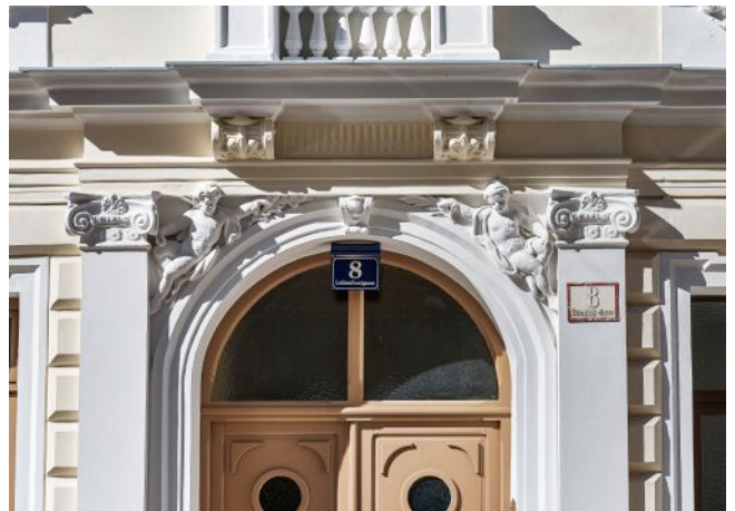
Leibenfrostgasse 8 | Fassade Detail
