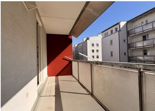
Balkon im OG
