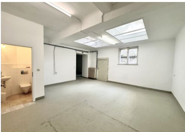
hofseitiger Raum mit WC
