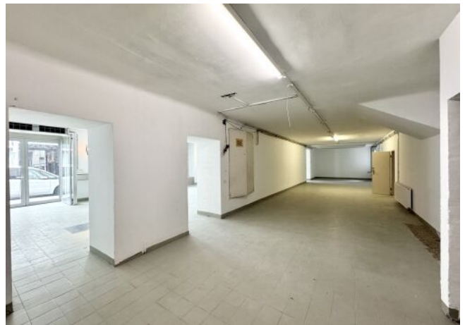
Raum mit Zugang zum Stiegenhaus
