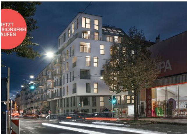
Arndtstraße 50 | Fassade Nacht
