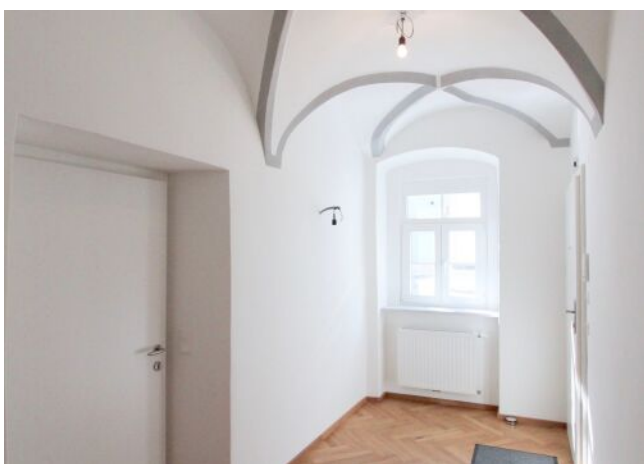
Kreuzgewölbe im Wohnbereich
