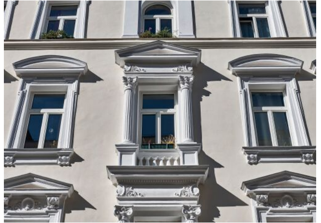
Leibenfrostgasse 8 | Fassade Detail
