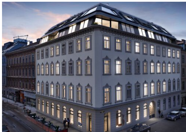
Essenz No. 1 | Fassade Abend
