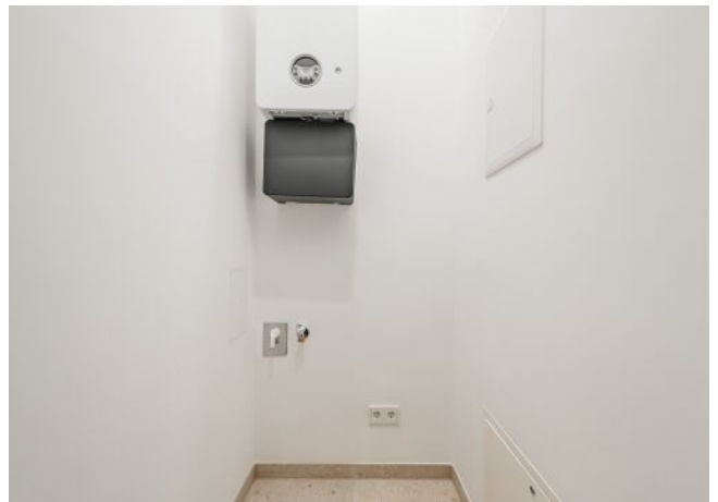
Abstellraum mit Waschmaschinenanschluss
